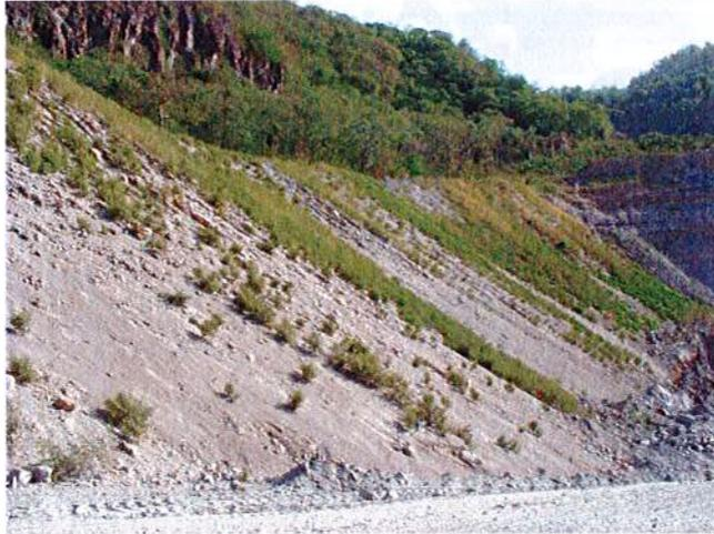
Figure 69 : Illustration de la mise en place d'un talus sur les derniers gradins pour améliorer l'intégration paysagère (2002)
